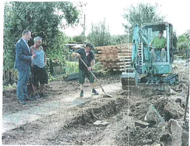
Christian Herrgott (l.) verschafft sich einen Eindruck von der Baumaßnahme in der Gartenanlage „Vogelstange“ in Neustadt. Thomas Greiling (2.v.l.) erläutert ihm die Arbeiten. Foto: Sandra Hoffmann
